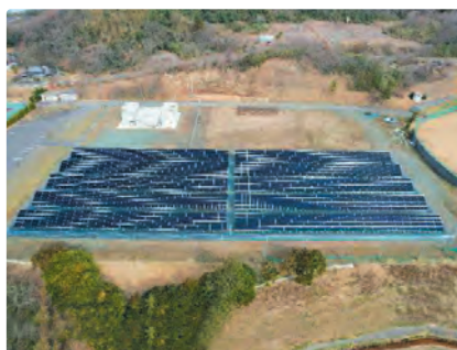
柏崎市西山町「浜忠太陽光発電所」
